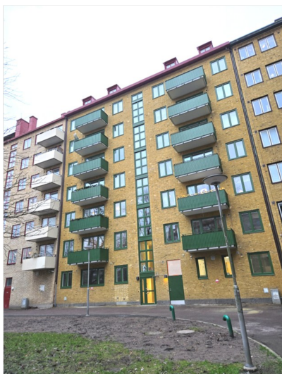
Nya fönster och balkonger
