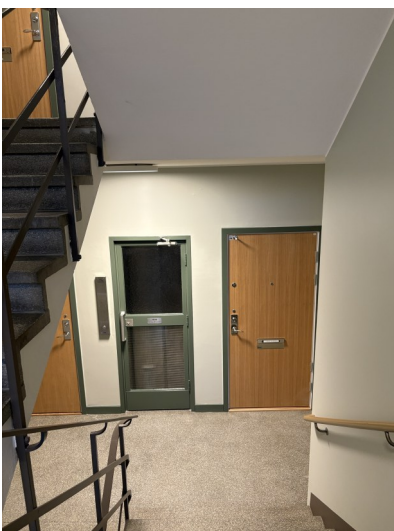
Nymålat trapphus och säkerhetsdörrar på plats
